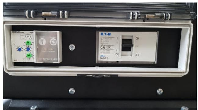
Der Generator ist über einen Leistungsschutzschalter gesondert abgesichert (ab TG30/15). Personenschutz ohne Erdungsspieß mit Isolationsüberwachung im Feldbetrieb.
